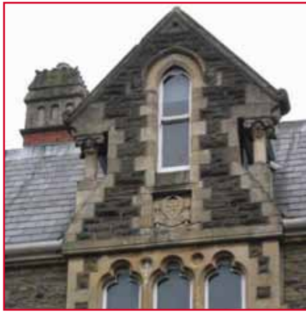
Manylion ar ffenestri dormer a'r simneiau yn rhifau 5 a 6 Plas-y-Parc.
